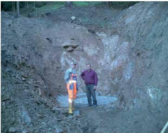
Da bei der oberen Wörnsdorfquelle 1 im abgelaufenen Jahr anhaltende Qualitätsprobleme bestanden und diese aus dem Versorgungsnetz ausgeleitet werden mussten, wurde nunmehr auch diese Quelle nach einem Projekt des Ingenieurbüro Moser und einer wasserrechtlichen Bewilligung im heurigen September/Oktobre neu gefasst. Dabei wurde festgestellt, dass der Fassungsbereich durchwurzelt war und dies zur Einsickerung von Oberflächenwässern führte.
