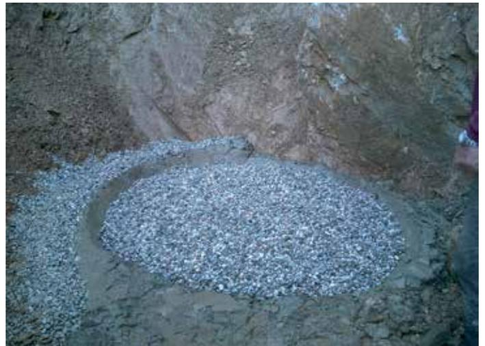
Bei der Wörnsdorfquelle 1 handelt es sich um eine Stauquelle, welche in einer Tiefe von ca. 4 m punktförmig lotrecht aus dem Festgestein austritt. Das Wasserdargebot der Quelle wurde durch die Neufassung von ursprünglich 26 m<sup>3</sup> auf 60 m<sup>3</sup>/Tag erhöht. Durch diese quantitative Verbesserung können Kosten für den Pumpbetrieb aus dem Brunnen zur Befüllung der Hochbehälter eingespart werden, weil die Wörnsdorfquellen im freien Gefälle abfließen.
