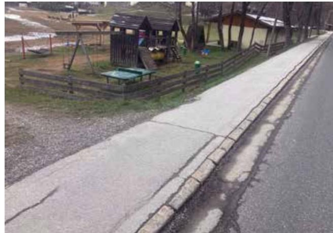
Nun folgt die zweite Etappe mit Beginn bei diesem Zebrastreifen bis hin zum Steinernen Kreuz. Der Gehsteig wird auf 1,50 m verbreitert und die Straßenbeleuchtung ident der 1. Etappe erneuert. Die Böschungsflächen werden mit dem Aushubmaterial angeschüttet, im Bereich des Sportheimes ist die Böschungssicherung mittels Rasengittersteinen geplant.
